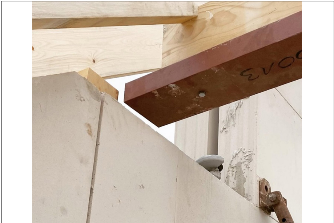
Abb. 3: Brandwandauflager (Quelle: Eigene Aufnahme)
